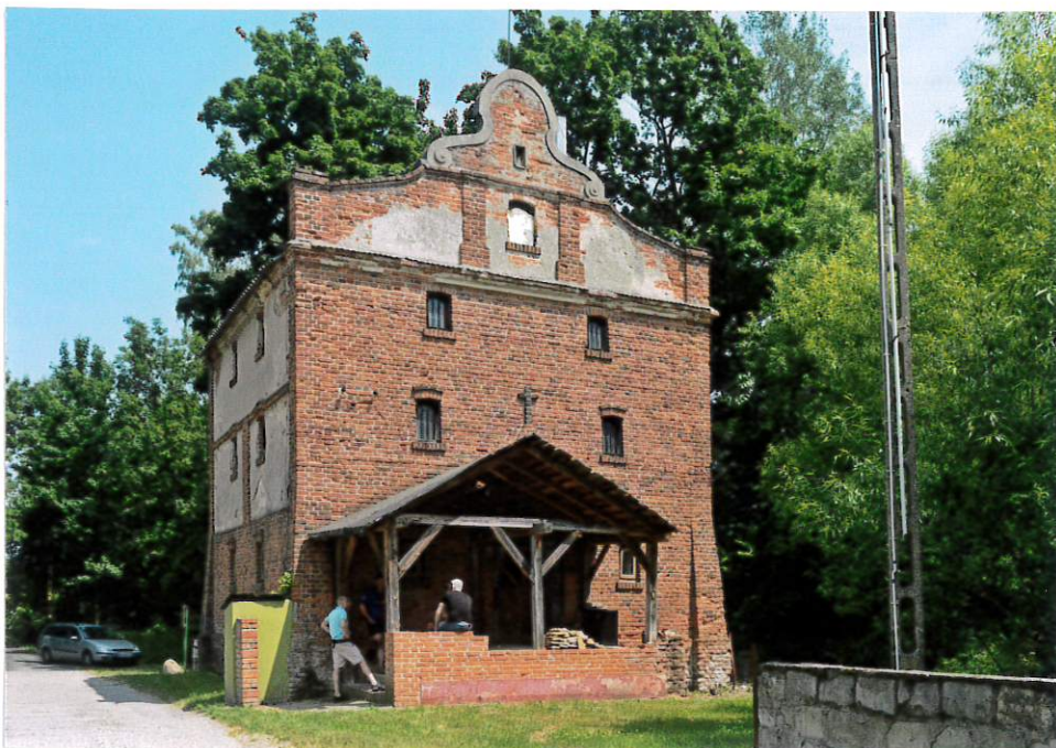
Fot. 1. Elewacja południowa, 2019.
