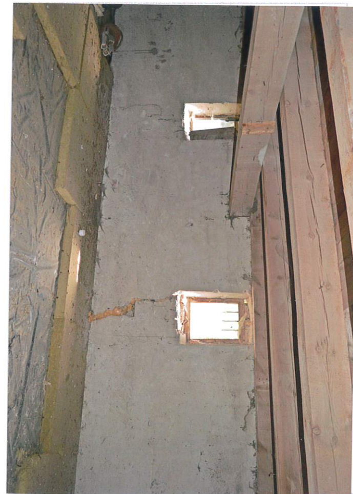
Fot. 8. Wnętrze – 2. piętro (widok na ścianę wschodnią z
